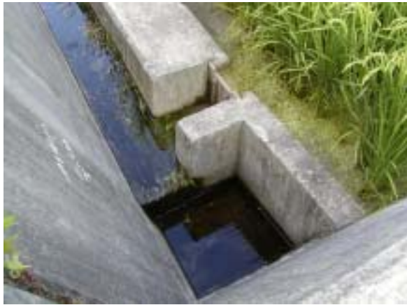
図5 コンクリート製の集水マス
