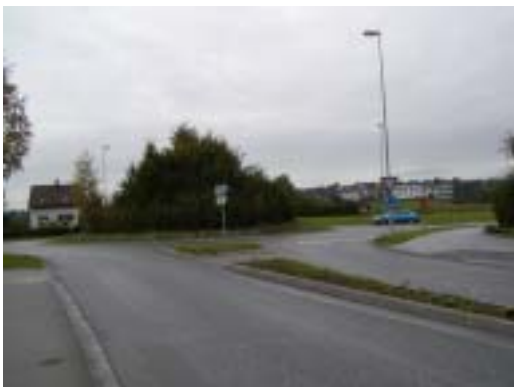
大きなロータリーでは中央を樹木で植栽し、自然環境を代償している。さらに、直進方向の見通しが悪いことで、ドライバーは慎重に交差点に入る。
