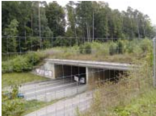
幅 100m のエコブリッジ。周囲にはネットフェンスが張り巡らされている。フェンスは、アウトバーン全線に整備されており、生きものと道路を分離している。
