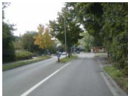
横断歩道の中央に設置された島状待避
