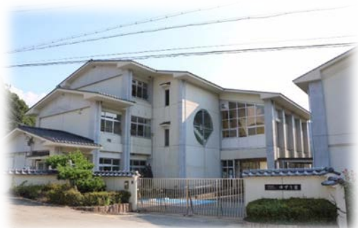
簡易宿泊施設「ゆずり葉」(旧天野小学校)
