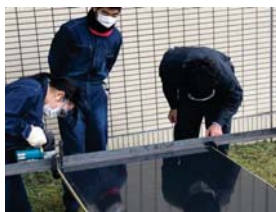
切り出し作業
