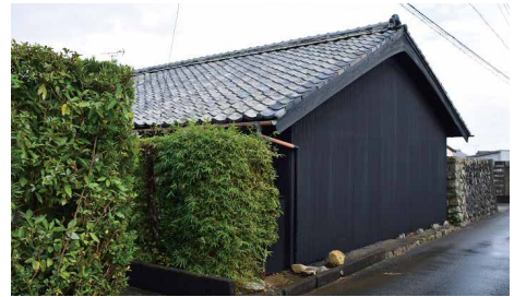
串本町潮岬の民家 防風のための石垣・生垣とコールタール塗りの外壁
