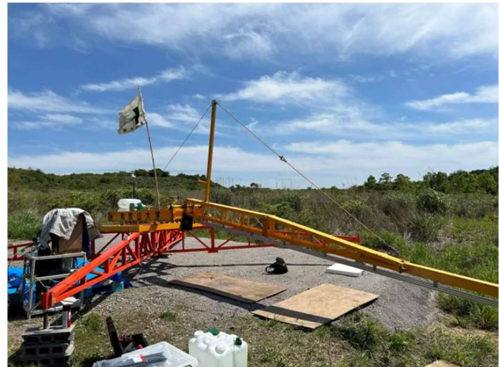
(写真 2.2.2. 打上に使用するランチャー)
