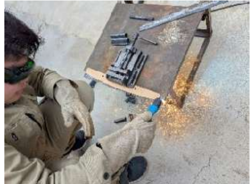
図6 曲線軌道の治具を製作する様子
