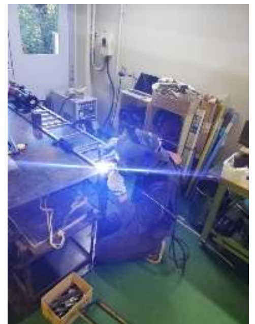
溶接作業の様子
