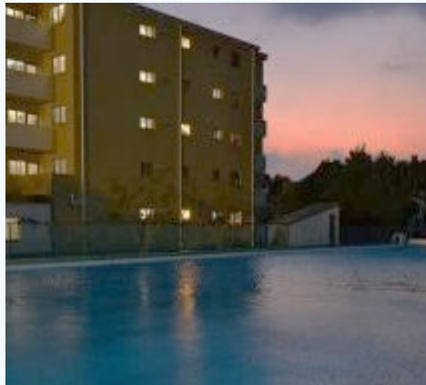
北のプール側から見た 黄昏時の男子居室棟
