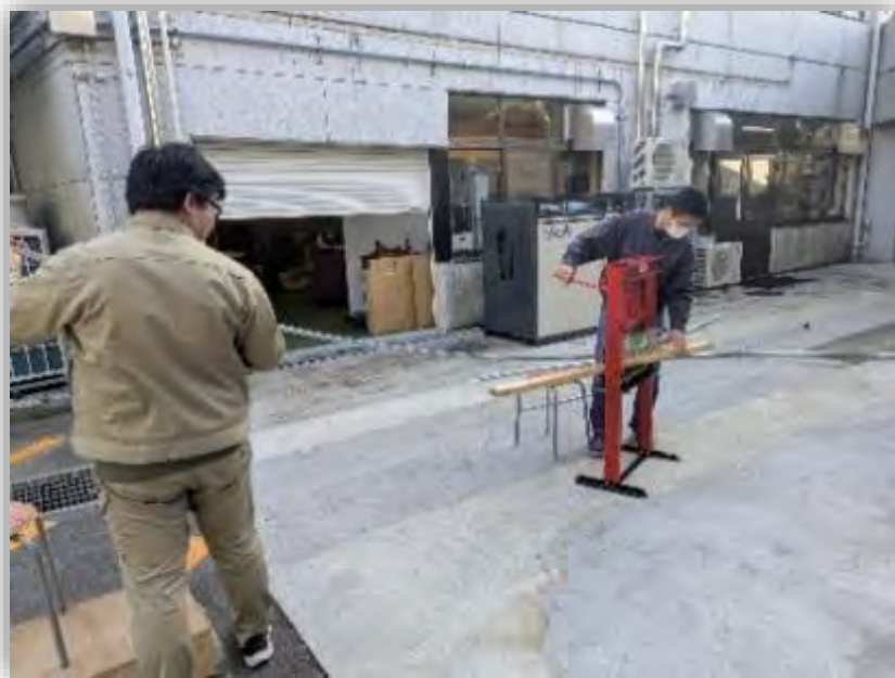
カーブレール用部品の曲げ加工
